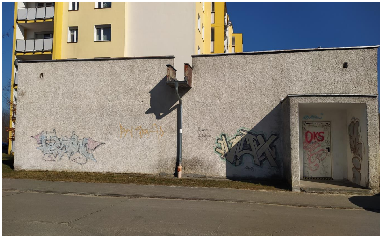
ściana czołowa z wejściem
